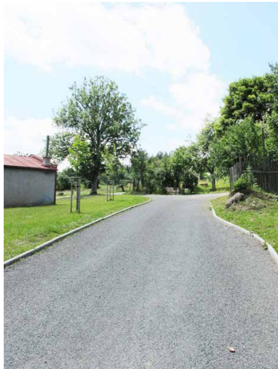
Cesta okolo obecního úřadu a za ním může sloužit za vzor, jak udělat takovouto jednoduchou, relativně úzkou a přiměřeně praktickou cestu s povrchem z hrubého asfaltbetonu.
